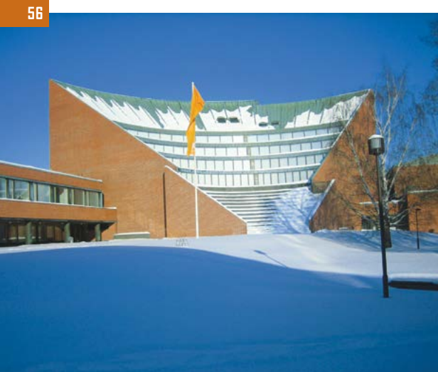
Campus auditorium van de Aalto universiteit. | Aalto-yliopiston kampuksen auditorio.
